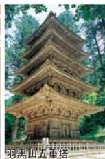
羽黒山五重塔 / 風雨にさらされ、豪雪にも負けず、東北の厳しい自然環境に600年耐え抜いてきました。
